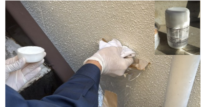
試料採取面の飛散防止のためKIKUSUI「アスウェットW」をウエス塗付
